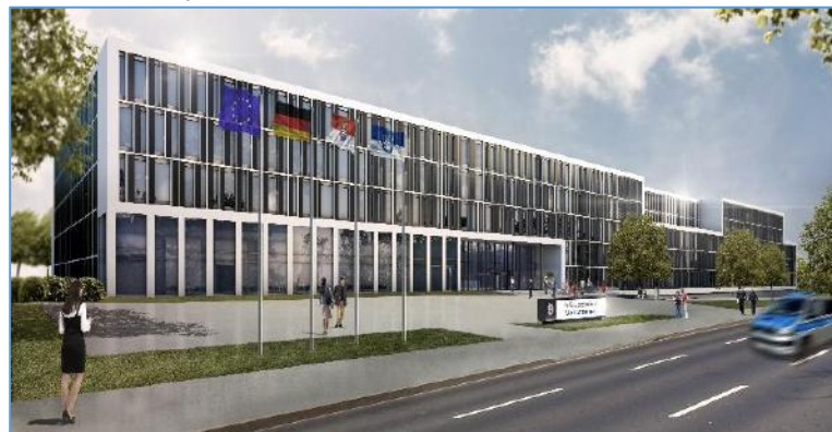
Neubau eines Verwaltungsgebäudes als Sitz des Polizeipräsidioms Süd – Ost Hessen
