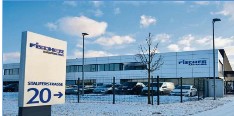
Neubau eines Büro- und Verwaltungsgebäudes
